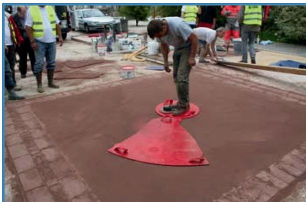
Il est important de positionner le plus justement cette seconde matrice car la position des suivantes en dépend. Pour d'autres formes de matrices ou de peaux voir le savoir-faire «Microchape».
