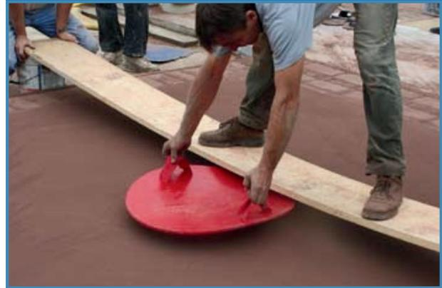
Avec une planche en guise de pont un applicateur peut placer sur le repère la partie centrale de la matrice.
