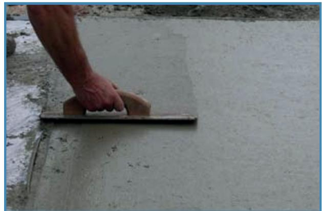
Utiliser une taloche à main pour les bords ou les détails.
