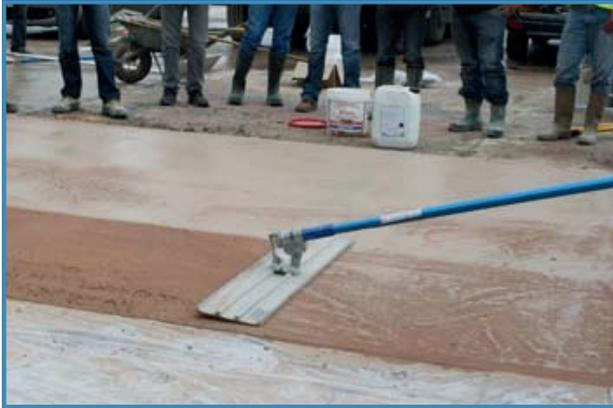
Le durcisseur est maintenant taloché ici avec une taloche à manche magnésium. La taloche lisse et mélange le durcisseur au béton. Elle se comporte comme une véritable bétonnière.
