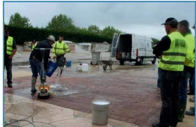
Verser le béton net dilué ici à 1 part pour 3 parts d'eau.
