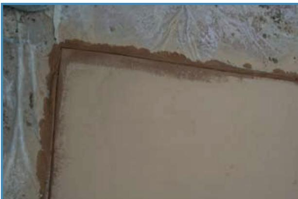
L'application du durcisseur généralement se fait en 3 couches : une première pour couvrir une deuxième pour corriger les endroits où l'on voit encore le béton de coulage et la troisième pour les bords.
