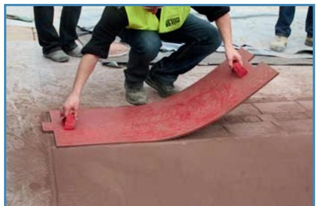
Pour enlever la matrice, la prendre et la soulever par deux extrémités bien verticalement pour ne pas abîmer l'empreinte. Ne pas oublier que le béton est encore frais
