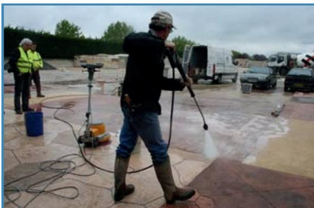
Laver le béton net au nettoyeur haute pression.
