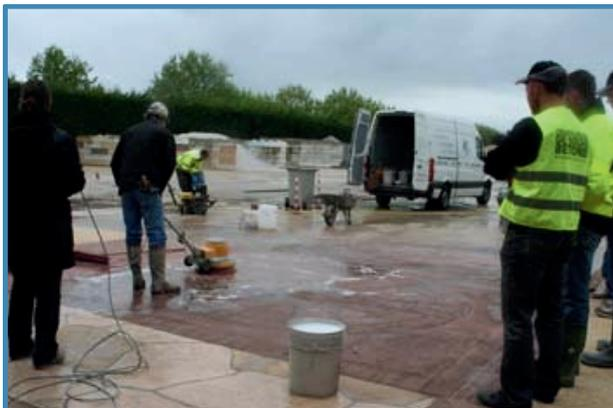
Passer la monobrosse équipée d'un pad (ici rouge, moins agressif, le béton est encore frais) ou d'une brosse à poils nylon (pour un chantier où le démoulant tient bien).
