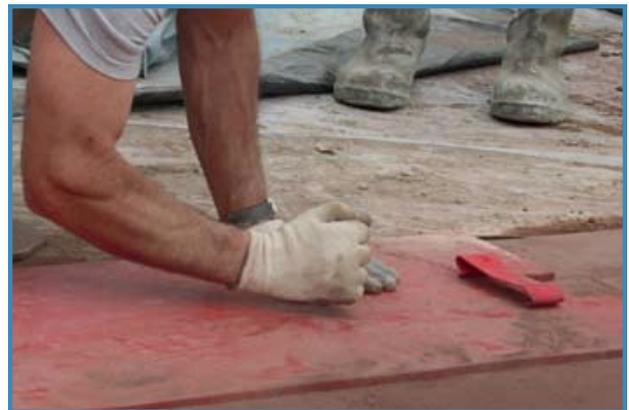
Dans ce cas on repose la matrice sans changer sa position et l'on tapote dessus au endroits peu marqués. Revérifier une seconde fois avant d'enlever la matrice.
