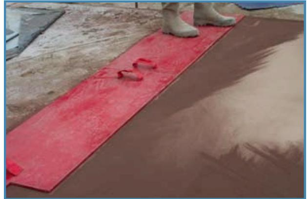
Placer la seconde matrice en respectant l'alignement. Ci-dessus on peut remarquer les clés en bouts de matrice qui permettent de les emboîter comme les pièces d'un puzzle.
