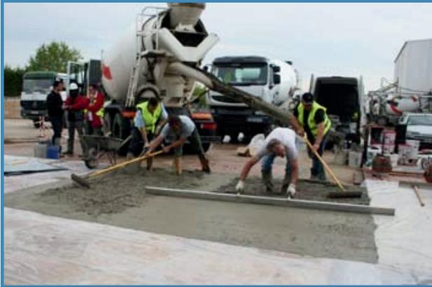
Répartir le béton à niveau avec des épandeurs et une règle. Récupérer le surplus et le mettre de côté. Attention à l'inclinaison de la règle à béton.
