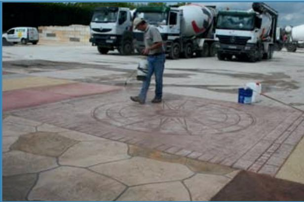
A l'aide d'un pulvérisateur à buse fine déposer une fine couche de vernis.
