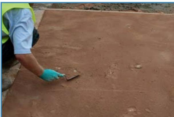
Délicatement à la spatule récupérer les grumeaux trop important : l'idée est d'avoir une diffusion homogène du durcisseur pour une couleur d'ensemble homogène.
