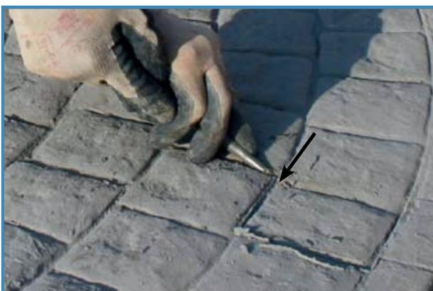
Le lendemain, alors que le Béton Imprimé est sec et que l'on peut marcher dessus (avec précaution) certains détails inaccessibles la veille pourront être corrigés à l'aide d'un fer à joints
