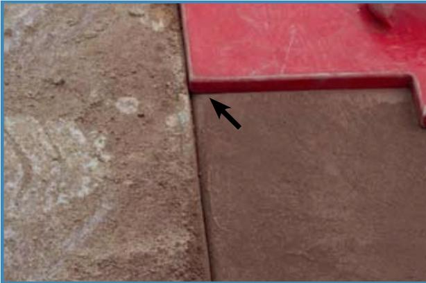
Poser soigneusement le bord de la matrice sur le bord du panneau pour éviter de marquer un joint où il ne faut pas.
