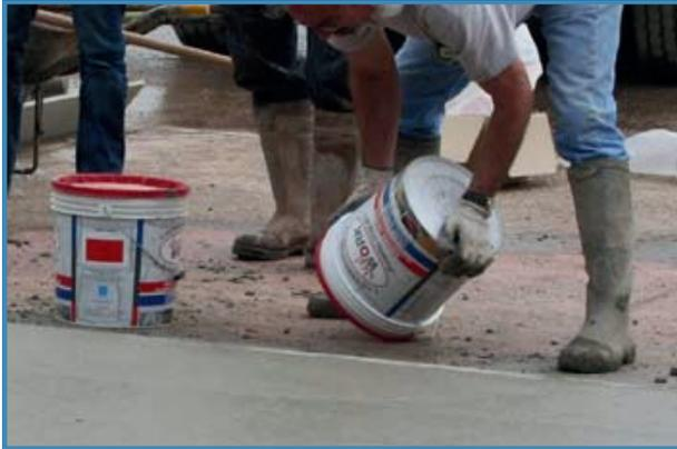
Agiter le seau de durcisseur avant l'utilisation afin d'aérer la poudre. Un seau permet de couvrir entre 6 et 8 m<sup>2</sup> en fonction de la couleur.
