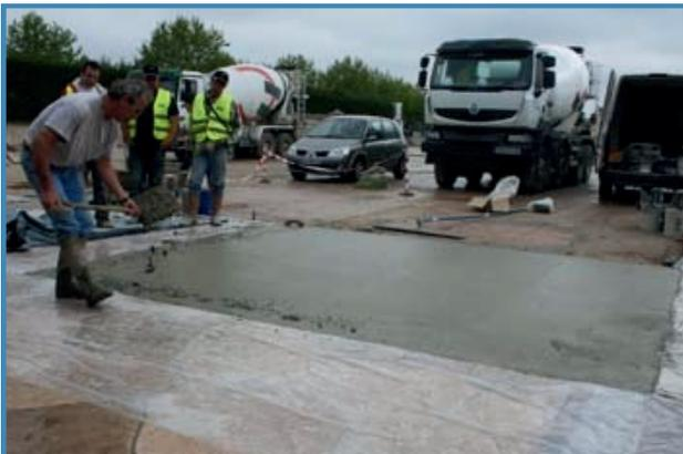
Parfois le béton descend en coulant au bas du coffrage, ne pas hésiter à en ajouter en utilisant le surplus du coulage à la pelle...
