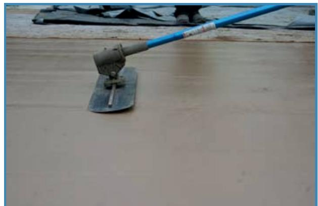
Incliner la lisseuse légèrement et croiser le mouvement si le chantier le permet.
